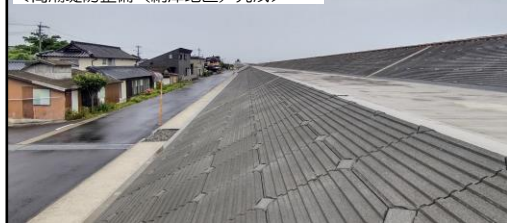
高潮堤防整備状況 （緑川下流左岸：TP 6.0対応）
